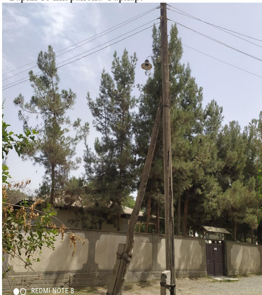
Фото: Состояние опра
