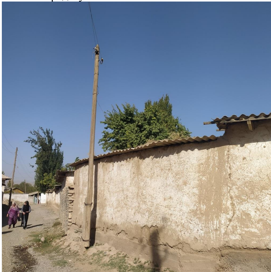
Фото: Состояние опор
