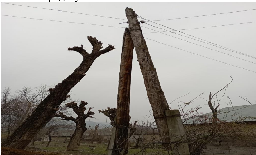
Фото: Состояние опор
